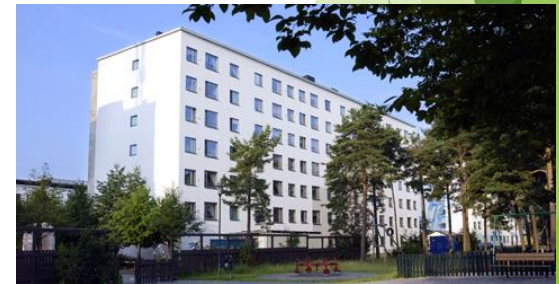
Byggnaden utnyttjas som lagring
